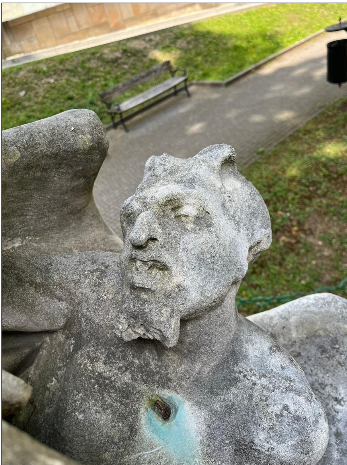
Widoczne niebiesko zielonkawe przebarwienia kamienia spowodowane przez włóczęgę wykonaną z miedzi lub brązu. Zagłębienie w ciele Lucyfera pozwala na precyzyjne określenie kierunku włóczęgi w przestrzeni.
