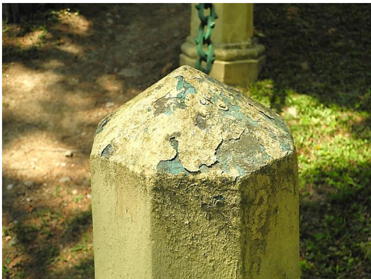
Słupek ogrodzenia – widoczne uszkodzenia powłok malarskich.
