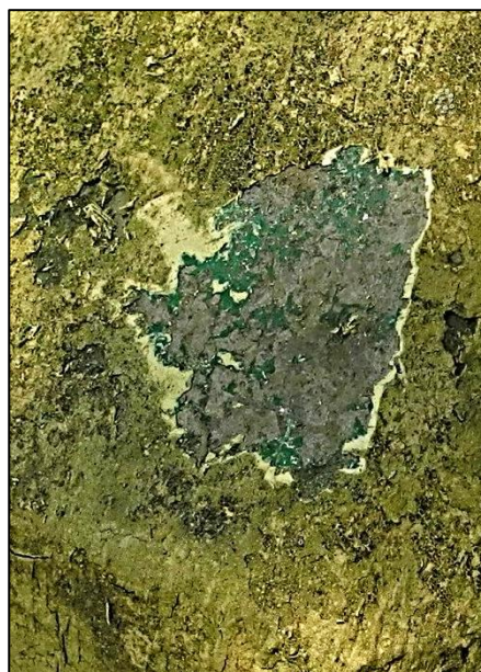
Słupek ogrodzenia – widoczne nawarstwienia malarskie.
