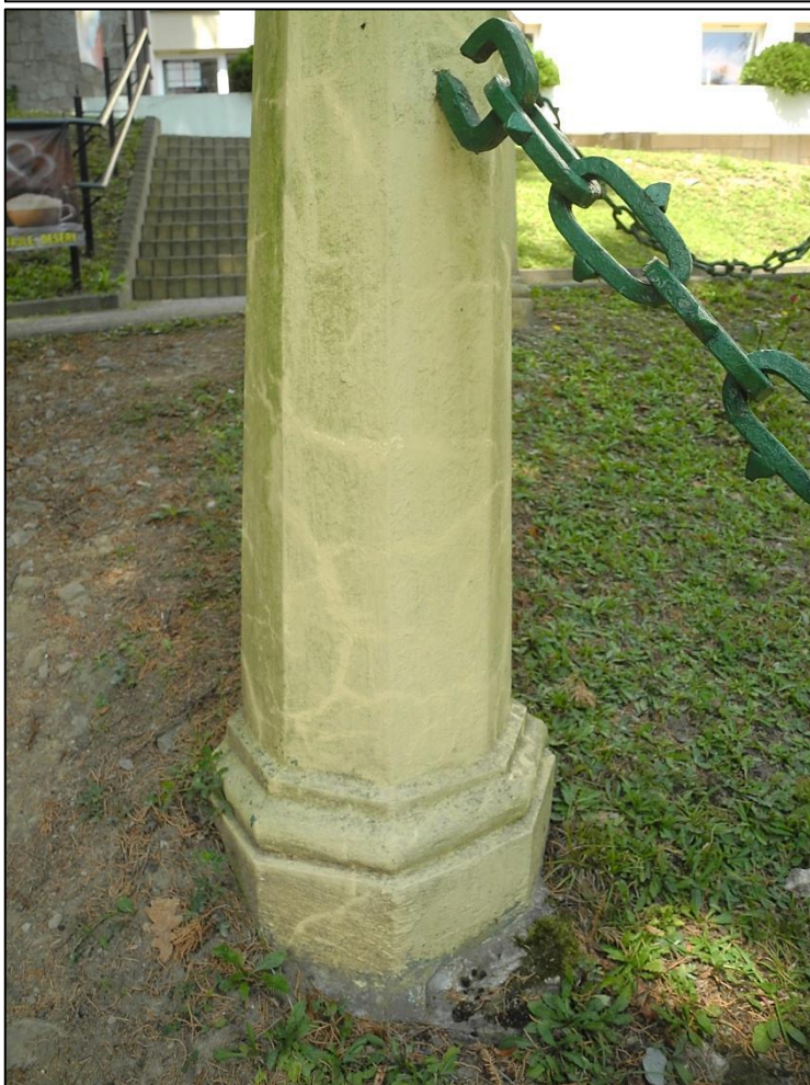
Słupek ogrodzenia – widoczny rozwój mikroflory, przebarwienia i zarysowania farby.
